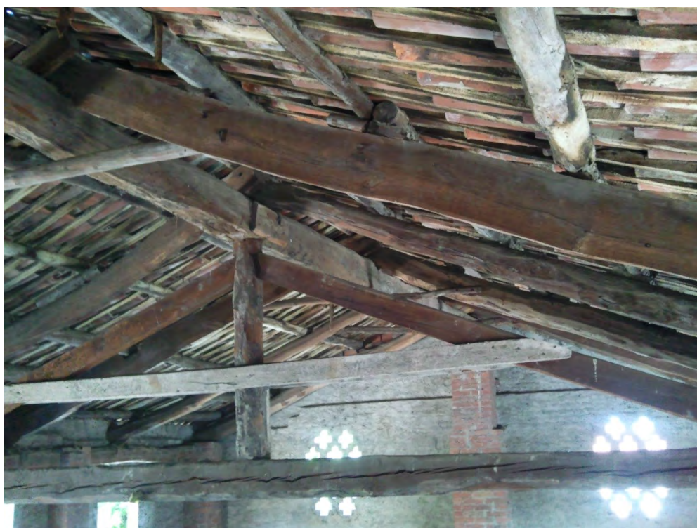
FOTO 8. Vista interna: struttura lignea della copertura esistente
